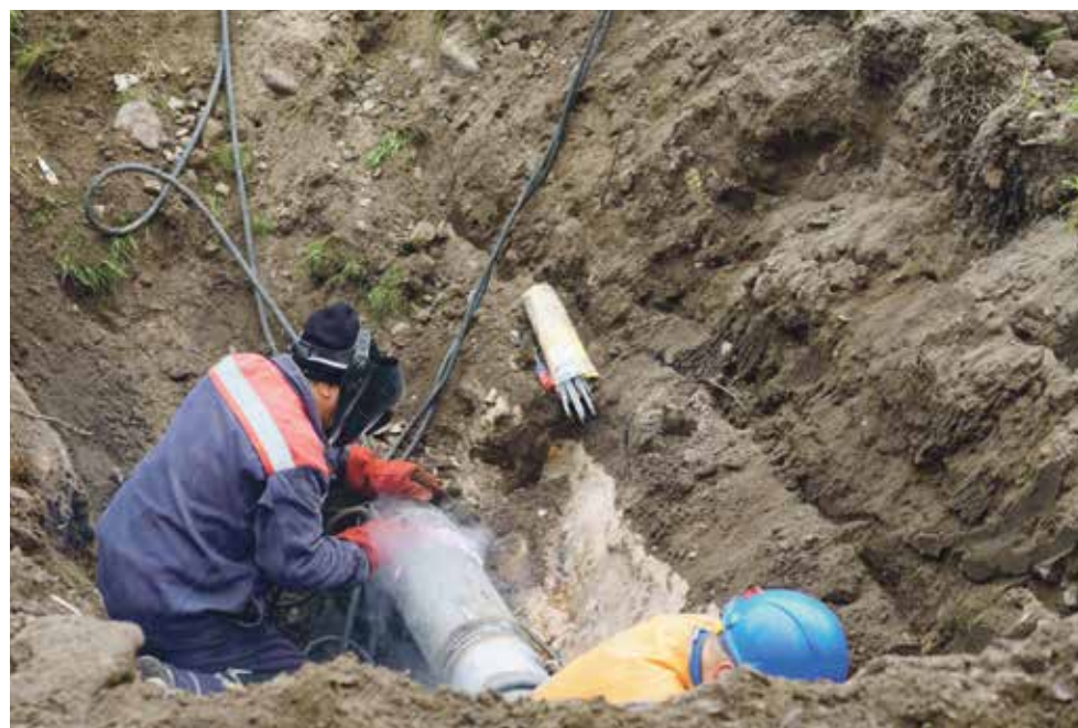
Miasto wybuduje prawie 6 km kanalizacji i dwie przepompownie ścieków, co pozwoli podłączyć do sieci ok. 150 nieruchomości.
