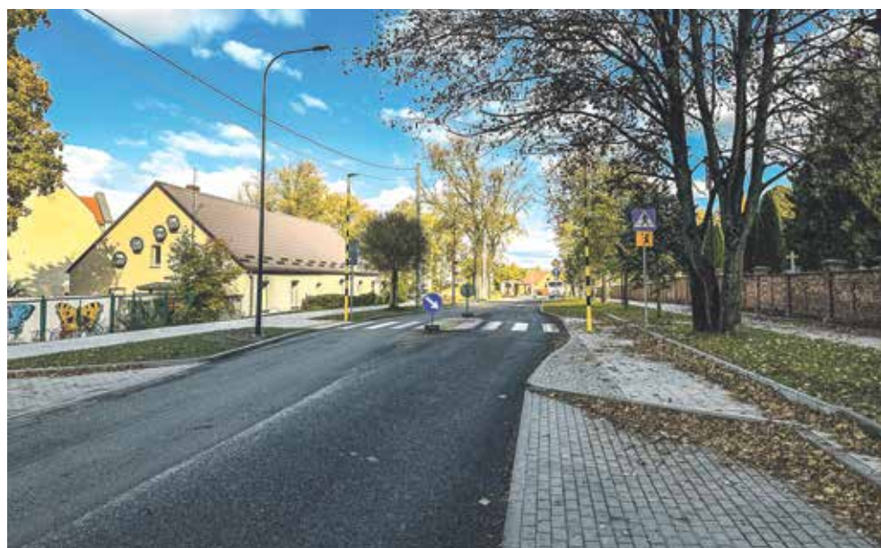
■ Przy ulicy Szwoleżerów pojawiły się zatoczki: autobusowa i postojowe oraz nowe rondo łączące ją z ulicą Chojnicką.
