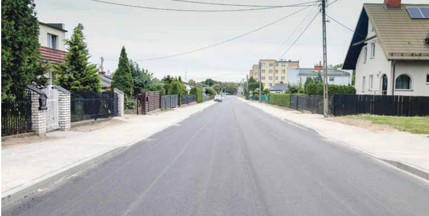
■ W lipcu 2024 roku Miasto zakończyło modernizację nawierzchni ulicy Ściegiennego.
