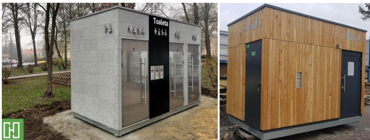
Ryc.26-27. Toaleta w Lubinie została osadowiona na podwalinach, bez fundamentów oraz przykład niewielkiej toalety o elewacji drewnianej ( www.hamsterpolska.pl oraz materiały od firmy Hamster Polska sp z o.o.).
