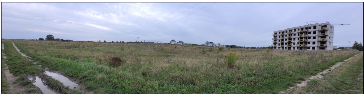
Fot. 6. Widok środkowej części terenu opracowania z projektowanej ulicy gen. Stanisława Sosabowskiego w kierunku północnym z widocznym powstającym budynkiem wielorodzinnym w terenie 33.MW.
