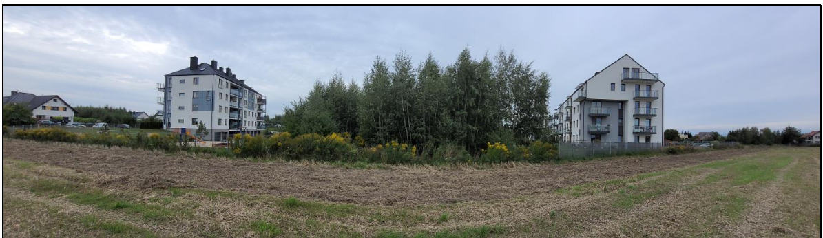
Fot. 5. Widok zadrzewienia brzoźowego wewnątrz zabudowy mieszkaniowej wielorodzinnej w północnej części terenu opracowania z terenów rolnych.
