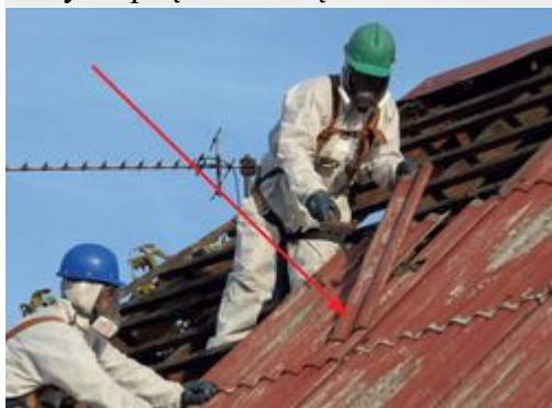
Etap 5) Płyty cementowo-azbestowe
