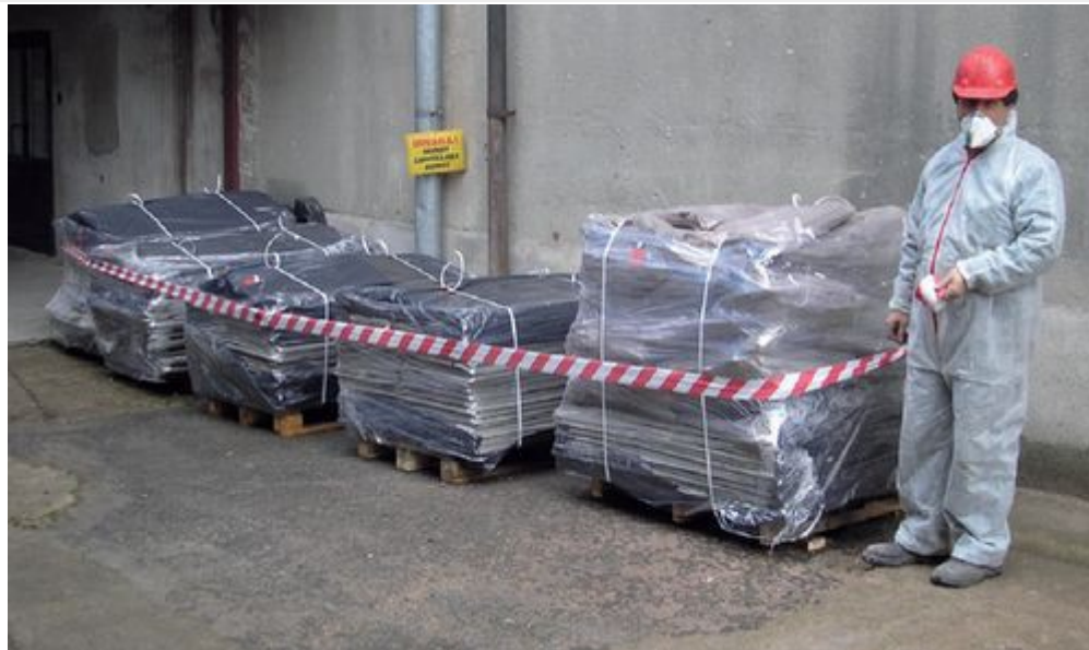
Usunięte płyty muszą być zabezpieczone folią polietylenową o grubości nie mniejszej niż 0,2 mm (fot. T.K.J. Matuszewski)
