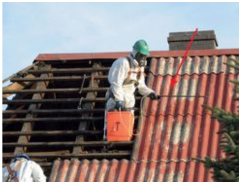
Etap 2) ...aby przed demontażem płyt zrosić je. Zmniejsza to roznoszenie się szkodliwego pyłu
